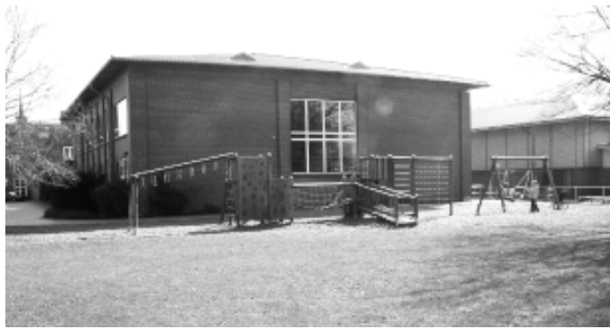
An diesem Schulteil soll der Erweiterungsbau der Eichenbachschule auf dem Grundstück des gemeindlichen Thingplatzes errichtet werden
