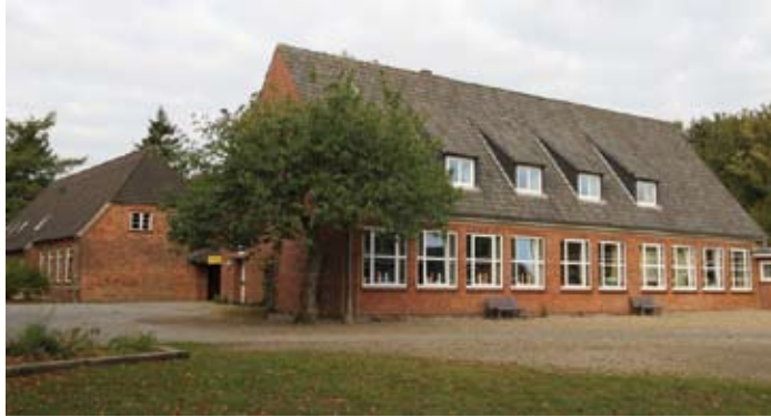
Das Dach des Schulgebäudes ist marode und soll saniert werden
